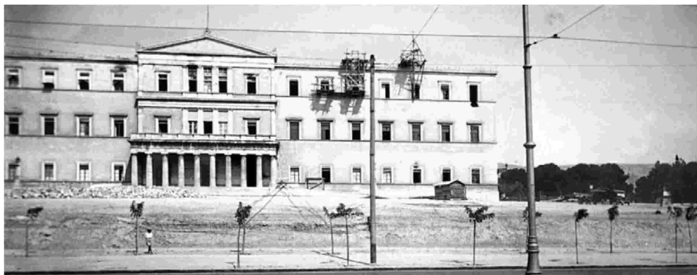
Τα Παλιά Ανάκτορα στη φάση διαμόρφωσης του χώρου για την κατασκευή του Μνημείου του Αγνώστου Στρατιώτη, περ. 1930.
